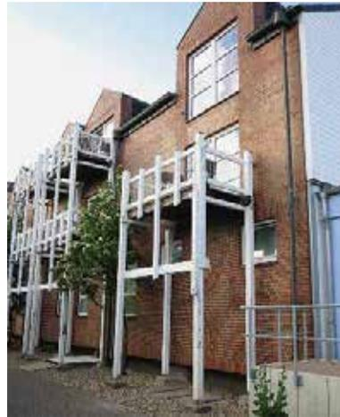
**Bild 6.** Befestigung eines Balkons (Foto: Küenzlen)
