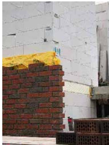
**Bild 32.** Beispiel für eine zweischalige Wandkonstruktion: Innenschale bzw. Tragschale aus Porenbetonmauerwerk, Wärmedämmung, Luftschicht und Außenschale bzw. Klinkerschale (Foto: Künzlen)
