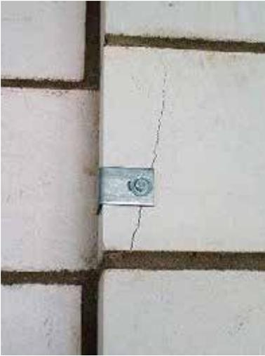
**Bild 82.** Zu geringer Randabstand bei der Montage eines Kunststoff-Rahmendübeln (Foto: Künzlen)
