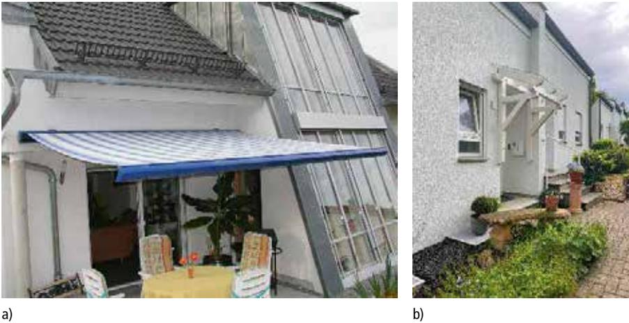
**Bild 29.** Befestigungen an einer (nachträglich) gedämmten Fassade; a) Markise (Foto: Adolf Würth GmbH & Co. KG),
