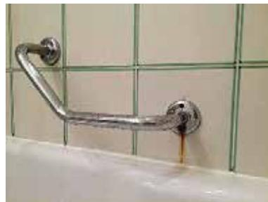
**Bild 78.** Galvanisch verzinkter Befestiger in einem Badezimmer (Foto: Küenzlen)
