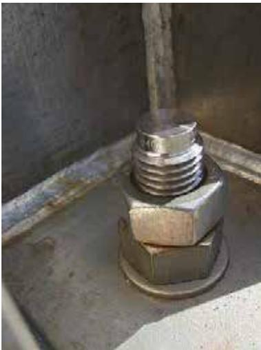
**Bild 80.** HCR-Ankerstange in Kombination mit A4 Mutter auf Helgoland (Foto: Küenzlen)
