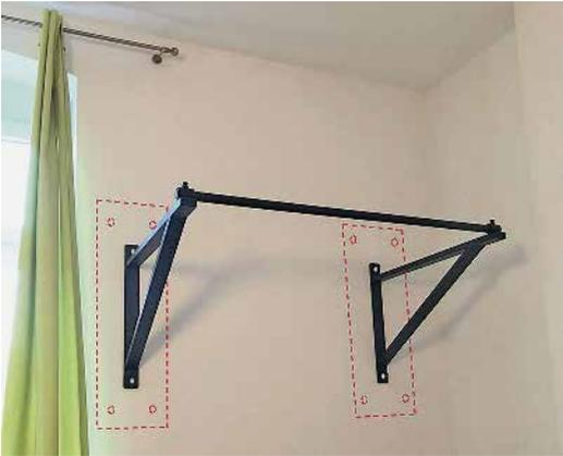
**Bild 53.** Fotomontage: Sind ggf. Zusatz-Ankerplatten für Klimmzugstange erforderlich? (Foto: privat; Collage: Scheller)
