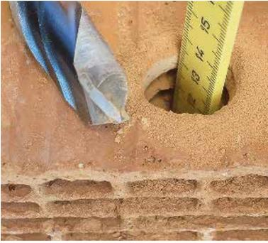
**Bild 16.** Probebohrung zur Ermittlung der Lochsteg-Geometrie in einem filigranen Hochlochziegel mit einem modernen Mehrzweckbohrer (Foto: Scheller)
