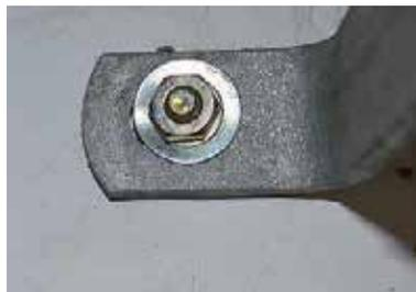
**Bild 51.** Fehlanwendung: Beispiel für zu großes Lochspiel zwischen Dübel und Durchgangsloch im Anbauteil (Foto: Scheller)
