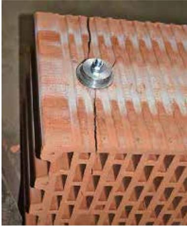
**Bild 68.** Spalten eines Lochsteins bei der Montage eines Injektionsdübels ohne Kontrolle des Drehmoments (Foto: Scheller)
